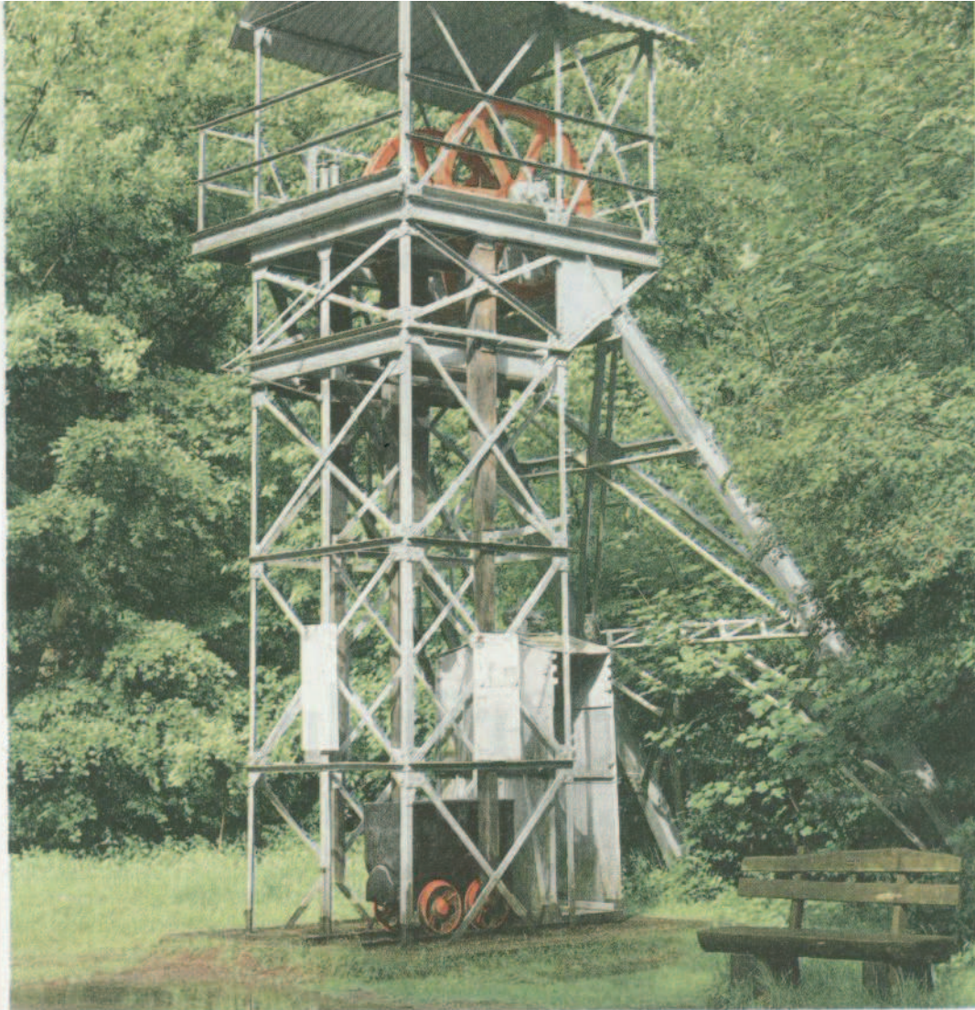
Der Franziskaschacht der früheren Grube Lüderich ist eine Station des Bergbauweges.
